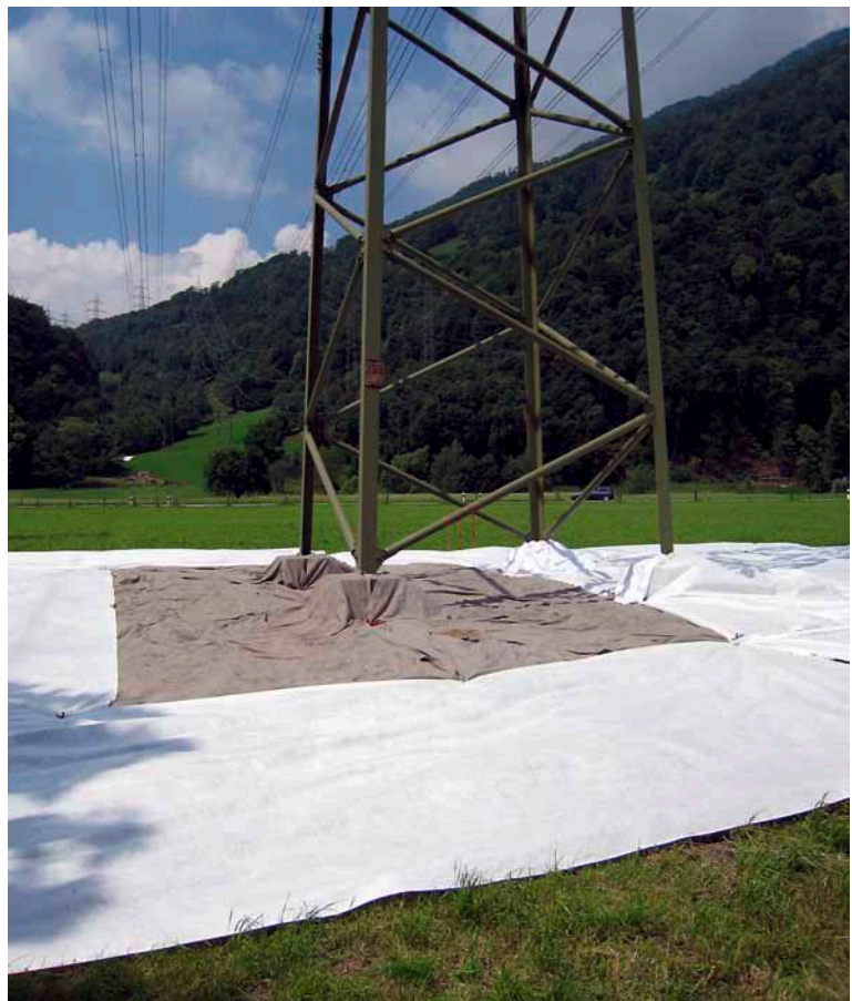
Couverture du sol adaptée à la situation
