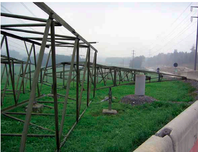
Pylone démonté
