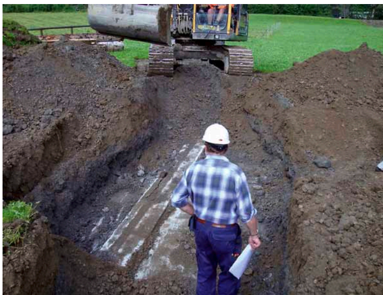
Tri de matériaux d'excavation pollués
