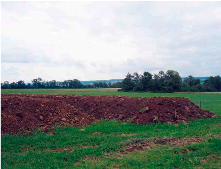
Stockage provisoire de sol (horizon A) et de sous-sol (horizon B)
