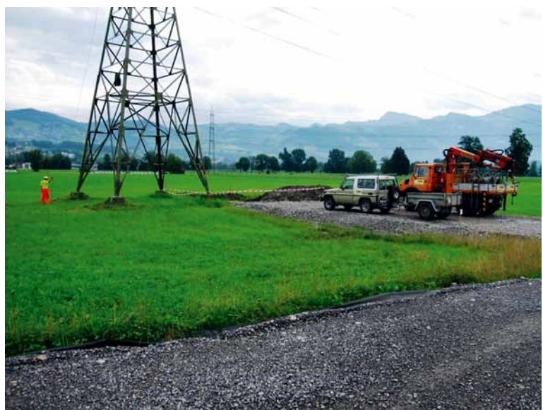
Zufahrt zu Maststandort mit Piste.
